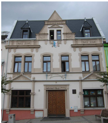
Obrázek 2: Mezi „nezateplitelné“ objekty patří mj. radnice v historických centrech měst. I v těchto případech je potenciál úspor energie nezdědky i 30 %. Výměna oken je po dohodě s památkovou ochranou možná, stejně jako zateplení střechy nebo stropu nad vytápěným prostorem, případně zateplení suterénu. Další úspory je možné dosahovat systematickým energetickým managementem – udržováním přiměřené teploty v kancelářích i společných prostorech, zvýšením účinnosti zdroje tepla (výměnou zdroje, pořízením akumulací nádrží, kaskádovým zapojením více zdrojů), seřízením a regulací topné soustavy, výměnou a řízením osvětlení, lepším řešením výroby a cirkulace teplé vody, pořízením úsporných spotřebičů a řízením jejich spotřeby atd.
